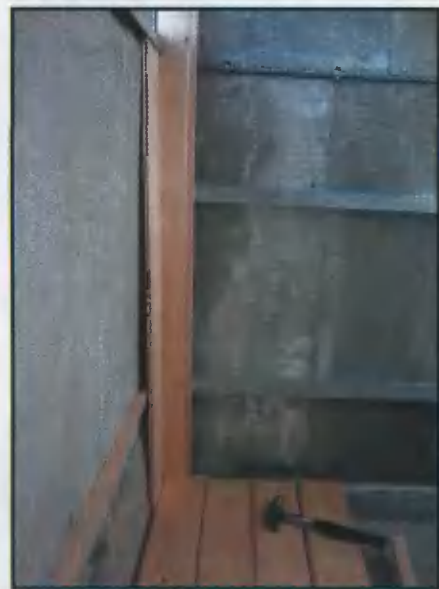
Половые доски уложил на лаги, не фиксируя настил. Окончательно пол смонтировал спустя несколько дней
