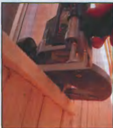
Окончательная отделка подоконника фрезерной и шлифовальной машинками
