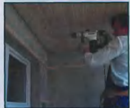
Хороший инструмент экономит время и упрощает работу. Отверстия в бетоне лучше сверлить перед началом «за один раз». После этой работы необходимо тщательно пропылесосить помещение
