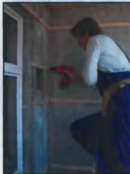
Бруски обрешетки крепил к стенам шурупами, заворачивая их в пластиковые дюбели
