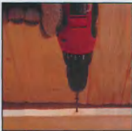
Для изготовления подоконника и порожка балконной двери я использовал две половые доски, нарастив целую половицу на треть
