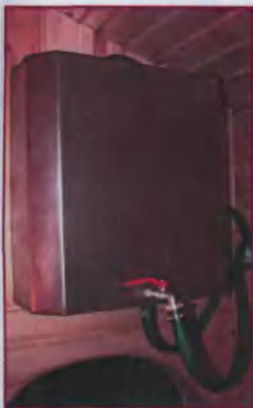
Накопительный бак с двумя штуцерами для пропуска холодной и горячей воды и краном для ее забора
