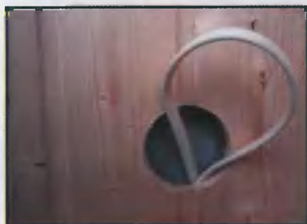
Заранее проложил кабель под электрическую розетку
