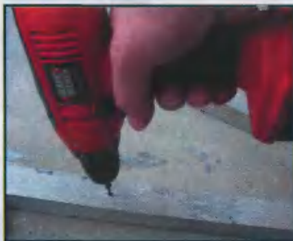
Лаги сечением 40х40 мм покрасил эмалью и прикрепил к бетонному полу шурупами, закручивая их в пластиковые дюбели
