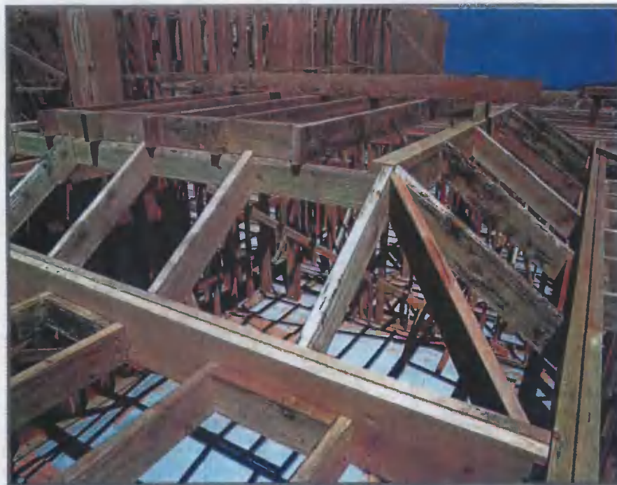
После установки несущего короба на свое место, все остальные работы похожи на возведение вальмовой крыши с усеченным верхом. Между перемычками несущего короба вбиты распорные блоки, не позволяющие доскам коробиться при высыхании
