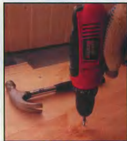
Доски пола зафиксировал шурупами, используя для этого шуруповерт
